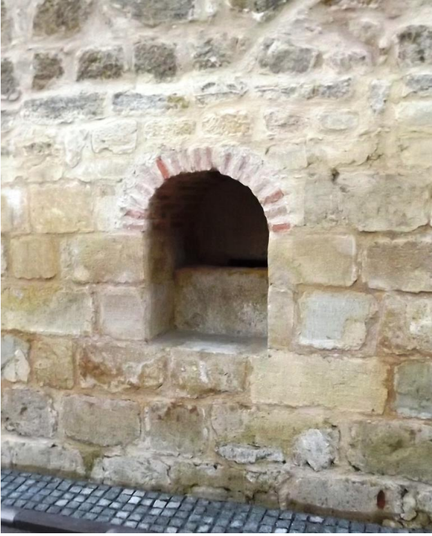
Fotoğraf No: 7 - Kastamonu Şa'bân-ı Velî Türbesi Kuzey Duvarı - Sebil Yapısı
