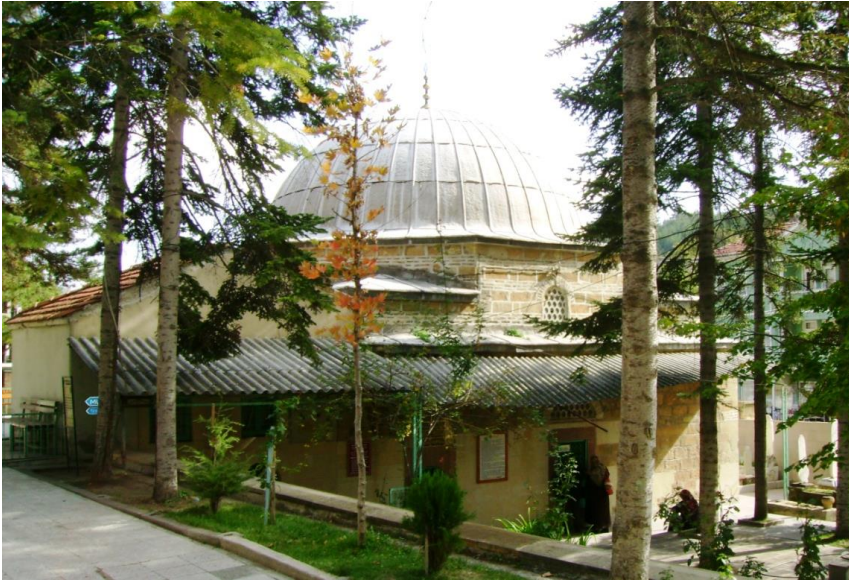
Fotoğraf No: 1 - Kastamonu Şa'bân-ı Velî Türbesi - Restorasyon Öncesi
