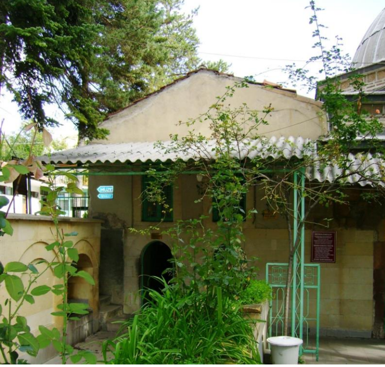
Fotoğraf No: 2 - Kastamonu Şa'bân-ı Velî Türbesi - Restorasyon Öncesi
