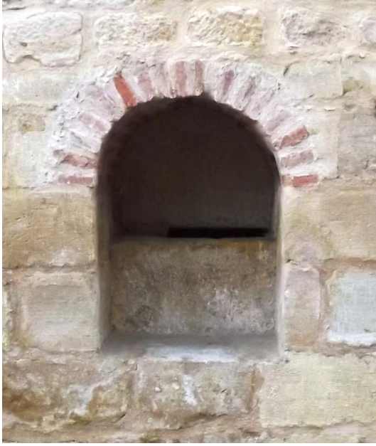
Fotoğraf No: 8 - Kastamonu Şa'bân-ı Velî Türbesi Kuzey Duvarı - Sebil Yapısı
